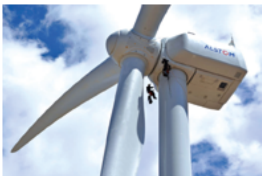
Réparation d'une éolienne, USA
