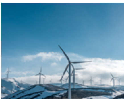
Éoliennes en montagne, Grèce
